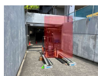
②揚重～地下2階へ運搬
