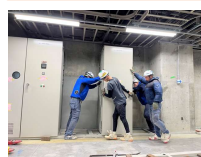
④特殊な台車を用いて、所定位置へ設置
