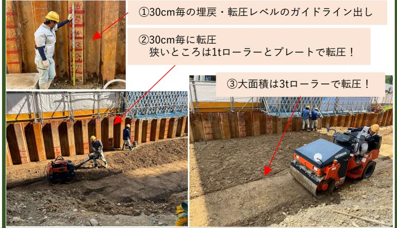
①30cm毎の埋戻し・転圧レベルのガイドライン出し
